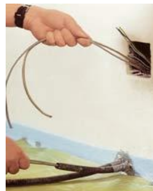
Abbildung 9.2: Unterputzdose mit Bodenfühler-, Leer- und Schutzrohr sowie Leerrohr für Heizfolien-Anschlussleitungen und Zuleitung der Raumtemperaturkontrolle.
